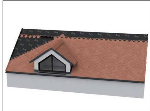
Bei größeren Dachunterbrechungen wie z.B. bei Dachhäuschen sollten Sie von der größten Teilfläche ausgehend mit der Verlegung beginnen. Wir empfehlen mittels Schnurschlaggerät die Gebinde fluchtgerecht abzuschneiden. Das Gebinde, welches als erstes komplett oberhalb der Dachunterbrechung über das gesamte Dach verläuft, komplett fluchtgerecht abschneiden.
